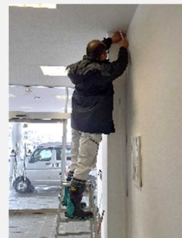
新潟 Tリーダー 配線カバー取付中
