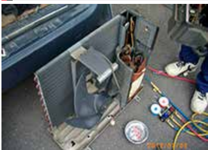
ルームエアコン修繕
