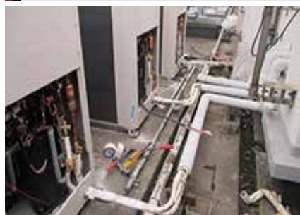
空調機更新工事(老人ホーム)
