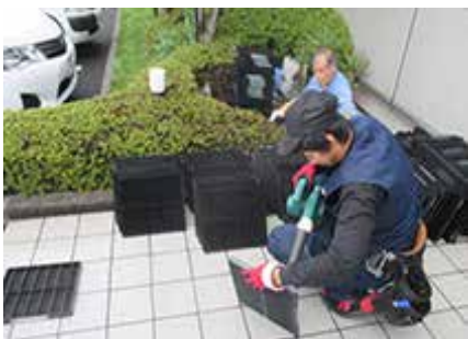
空調機保守管理
