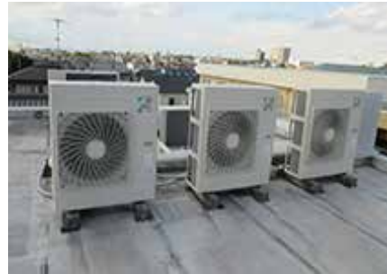
工場用空調設備工事
