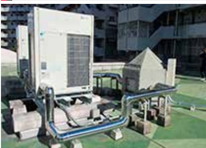
空調機更新工事(老人ホーム)
