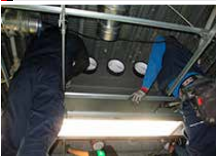
空調機更新工事(ビル)
