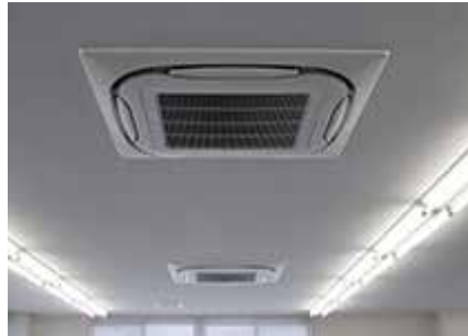
新築空調設備工事(老人ホーム)
