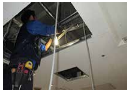
空調機更新工事(店舗)
