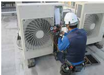
業務用空調機修理
