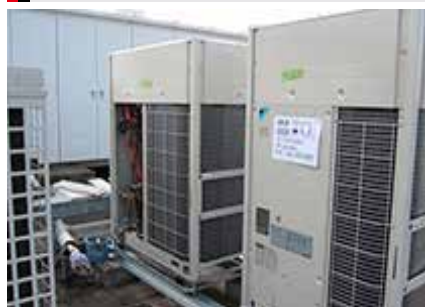
ビル用マルチエアコン更新工事
