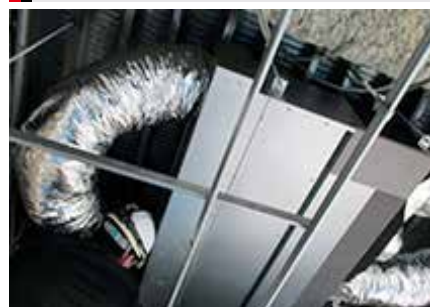
空調機更新工事(室内機)
