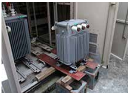
変電室改修工事(老人ホーム)
