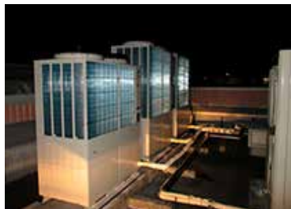
空調機更新工事(ドラッグストア)
