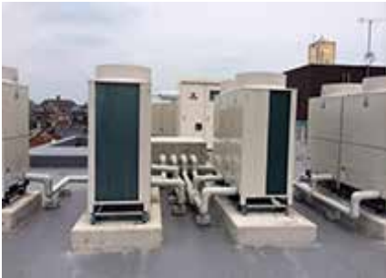
新築空調設備工事(老人ホーム)
