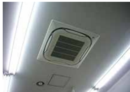
空調機更新工事(ドラッグストア)
